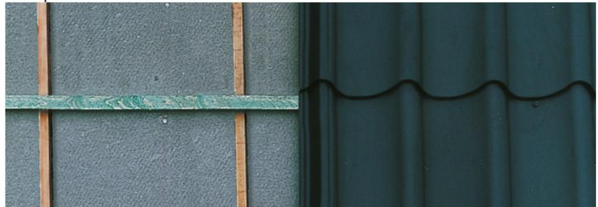
*Rénovation sur bardeaux bitumés, on peut appliquer la méthode 'toiture-sur-toiture'.*
